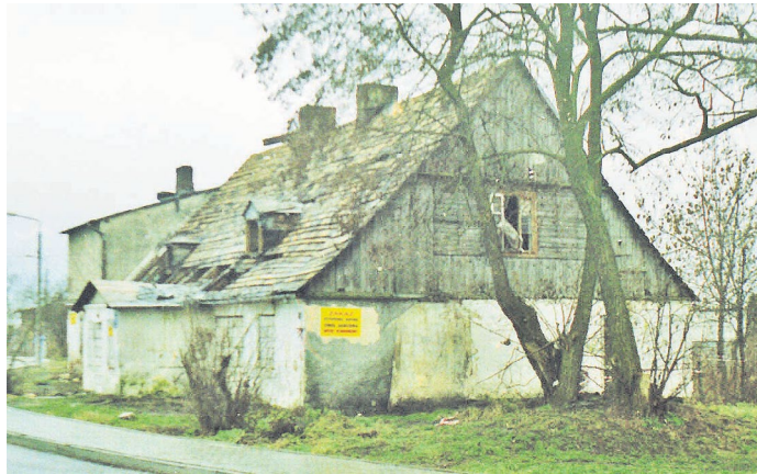
Szczurzyn dworek przed rozbiórką
