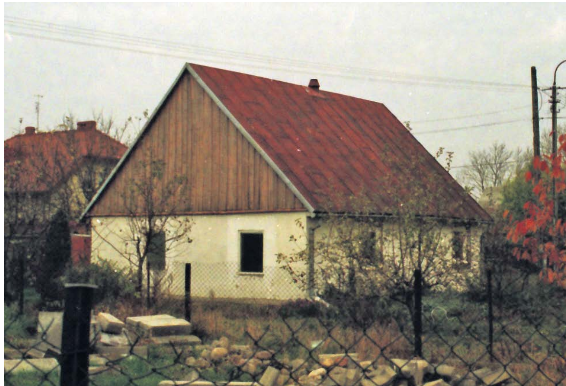
Dom ul. Wiosenna 9. Jeszcze daje się poznać, że to dawna budowla
