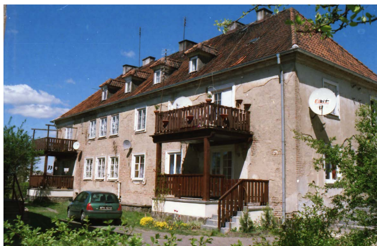
Dom ul. 17 Stycznia 78, jeszcze nieźle zachowany
